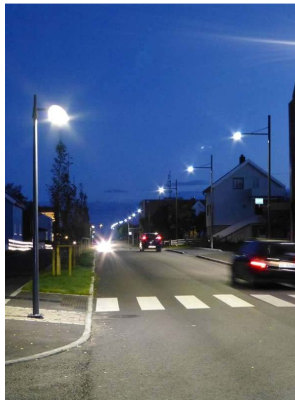
Figur 16. Gatebelysning langs Kongsvegen i LED-teknologi. Særleg merksemd er vidd ved fotgjengarovergangar. Trerekke i oppstamma rogn.
