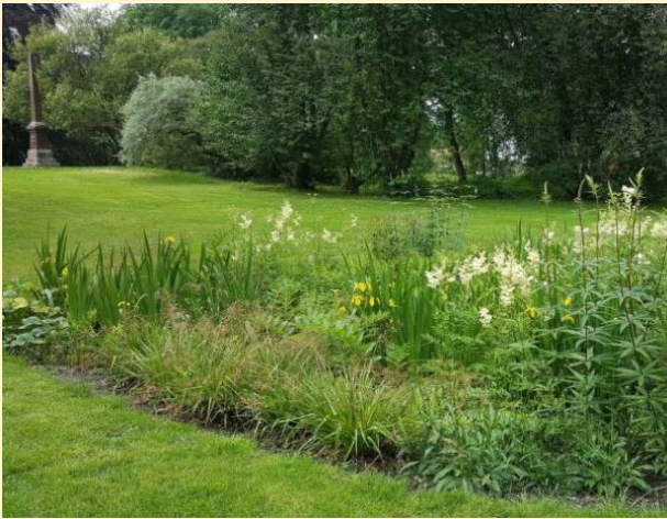
Infiltrasjonsareal/forsenkning med robust beplantning som tåler variasjon i vanntilgangen
