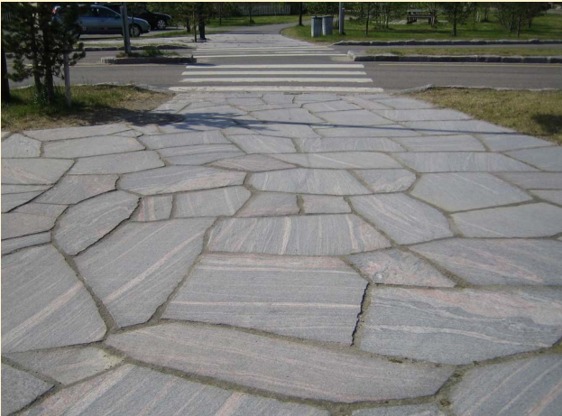
Skiferdekke over Kongevegen
