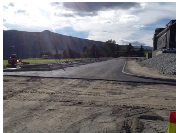
Anleggsarbeider i gang på Dombås vest sommeren 2014.
