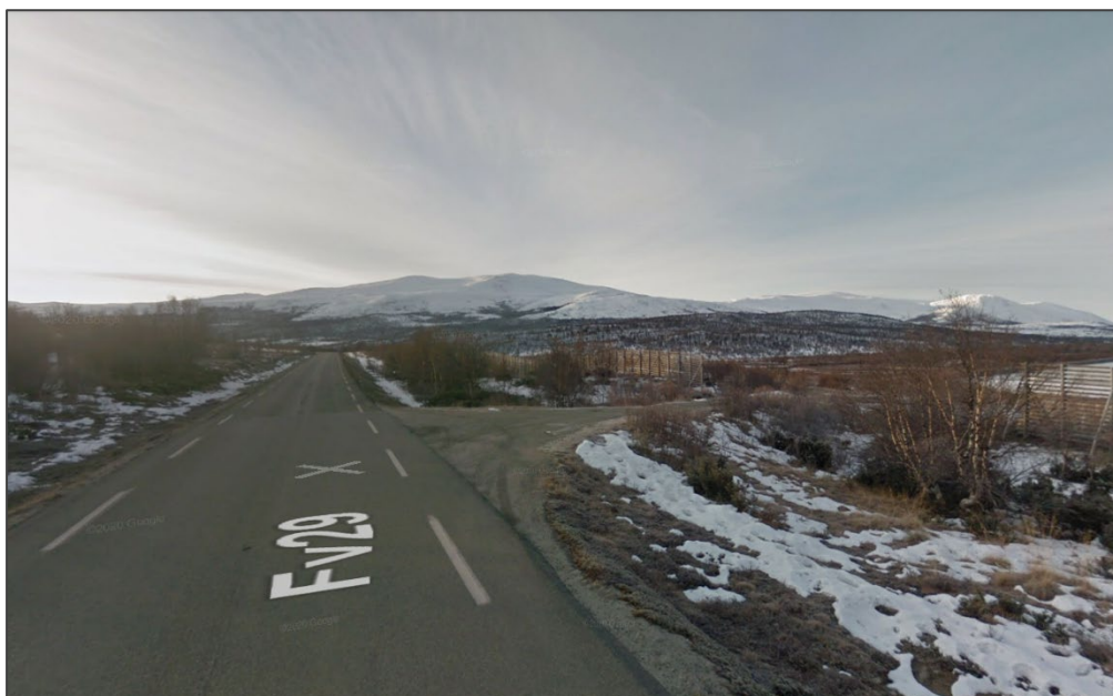
Eksisterande avkøyrsløse frå fv. 29 mot Hjerkinndammen, sett i retning Folldal. Utsnitt frå Google maps.
